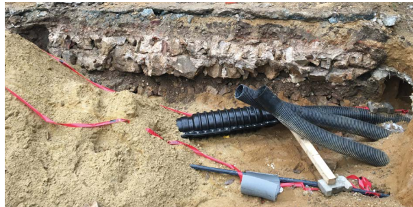
3. Nach dem Essen statten die fünf Museumsleute der Baustelle einen Besuch ab. Wann sieht man schon mal diese alte Mauer im Original? Die neuen Leitungen für das Kreishaus haben das Kastell durchschnitten, es liegt direkt unter unseren Füßen. Hinter dem Tor, auf der Düsseldorfer Straße, sieht man den Verlauf durch einen grauen Pflasterstreifen markiert.
