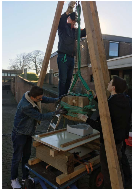
14. In der Museumswerkstatt wird der Herkulesstein mit der alten Technik von Dreibein und Flaschenzug für die Präsentation gesockelt und transportiert (Jacek Grubba, Hans Renn, Lucas Kapust).
