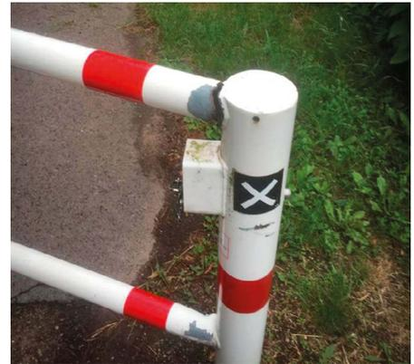
Durch massive Gewalteinwirkung ist die Rohrkonstruktion der Wegsperre am Barmener See erheblich beschädigt worden.
