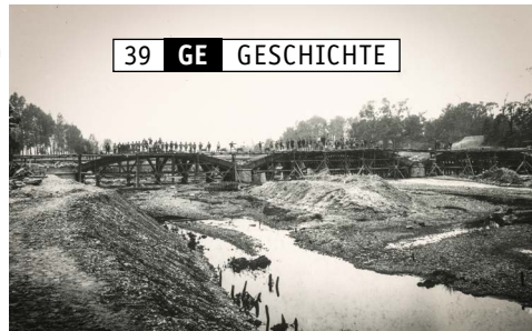
Abb. 6: Bau der Rurbrücke im Jahr 1902.
