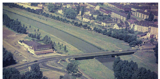
Abb. 16: Luftaufnahme der Rurbrücke.
