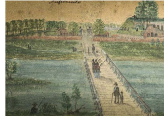
Abb. 3: Die französische Schleusenbrücke. Blick aus Richtung Stadt, der Brückenkopf im Hintergrund, um 1890. Die Holzkonstruktion vor der Brücke diente als Eisbrecher.
