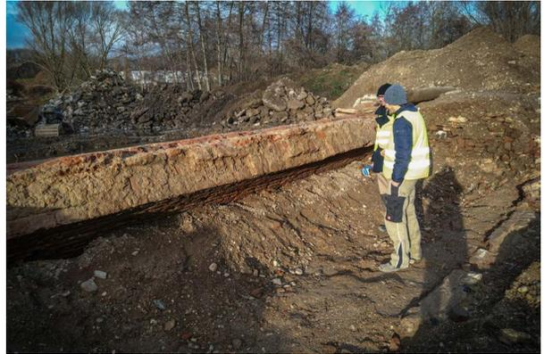
Ansicht des Gewölbeansatzes des Brückenaufagers, rechts Reste der Gegenmauer.
