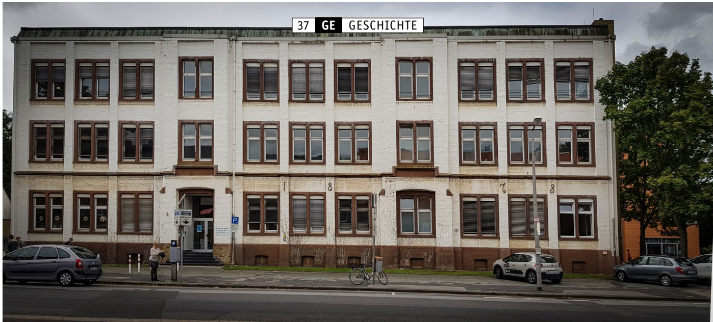
Abb. 2: Die Fassade des Westgebäudes des Gymnasiums Zitadelle: Die Maueranker belegen das Baujahr 1873. Der rechte Eingang, ursprünglich zur Knabenschule, wurde verschlossen. Ansonsten haben sich die historischen Fassadenelemente weitgehend erhalten.
